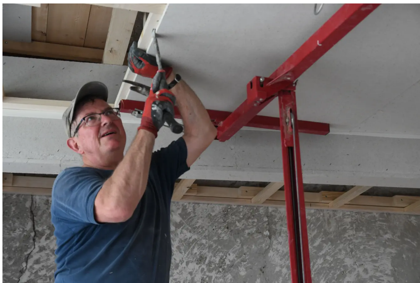
Montagearbeiten im künftigen Saal des Kirchenzentrums.
