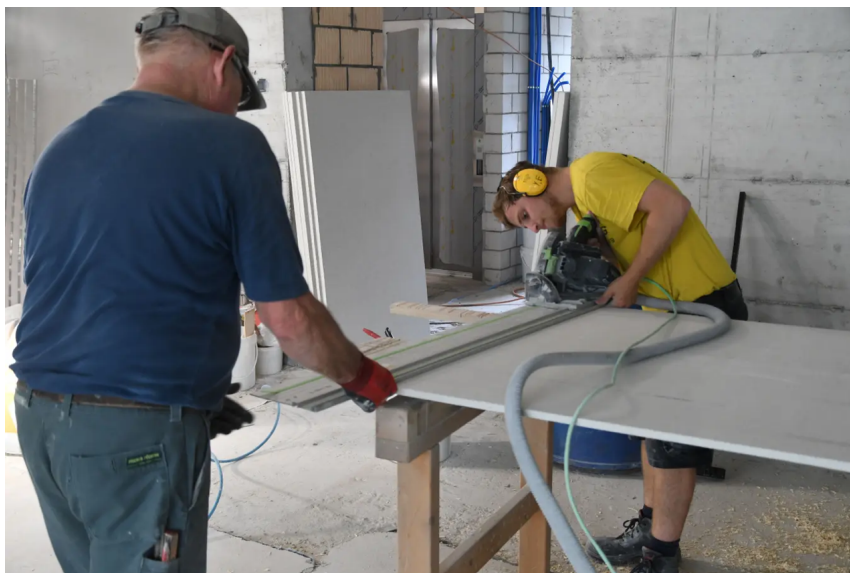
Eine Platte für die Decke des künftigen Saals im Kirchenzentrum wird millimetergenau zugeschnitten.
