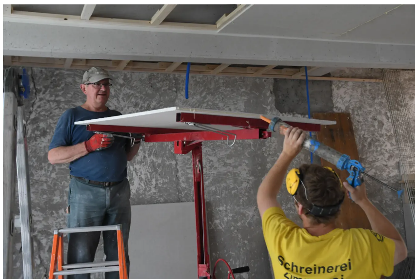
Montage der Deckenplatten im Erdgeschoss der Stiftsamtei.
