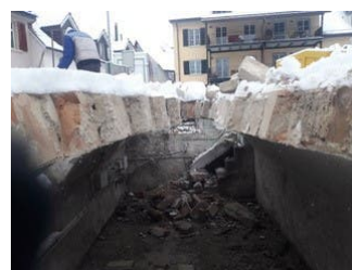
Abbruch des Gewölbekellers an der Bachstrasse im Dezember 2017.
