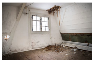
Blick ins Gebäude kurz vor dem Abbau im Dezember 2017.
