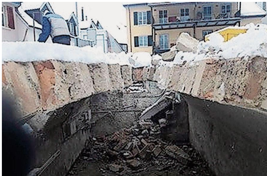
Blick in den freigelegten Gewölbekeller des 166 Jahre alten Wohnhauses an der Bachstrasse. (Bild: PD/Gabriel Müller)
