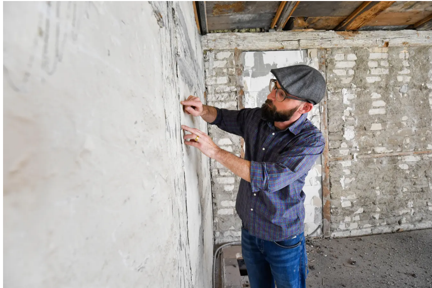
Christoph Biedermann, Gesamtleiter des Sanierungsprojekts, untersucht in der Stiftsamtei eine Gebäudewand.
