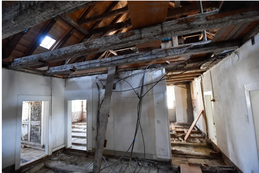
Blick in das oberste Stockwerk und auf den Dachstuhl der Stiftsamtei.
