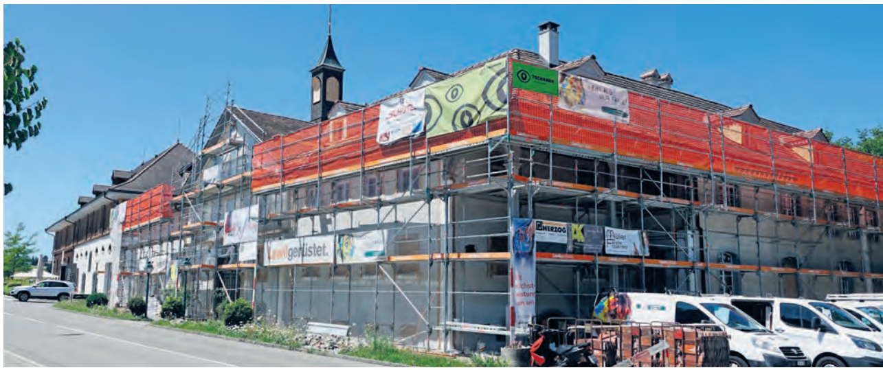
Der Greuterhof ist derzeit wegen der Fassadenrenovation von einem Gerüst umgeben.
