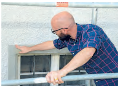
Bauleiter Christoph Biedermann erklärt Steinmetzarbeiten anhand der Fensterumrandungen.
